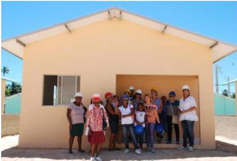
Figura 13.5 – Casa do Conjunto Habitacional Nova Tatuoca Fonte: Empresa Suape 87 .
