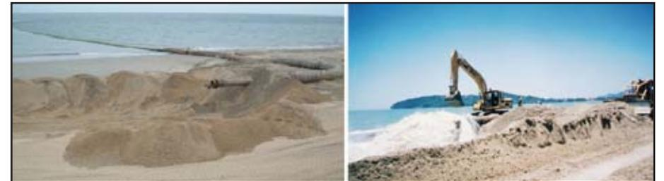
Figura 15. Tubulação para lançamento do material dragado (tubulação posicionada à esquerda) e operação de espalhamento do material na praia (direita). Fonte: Google Imagens.
