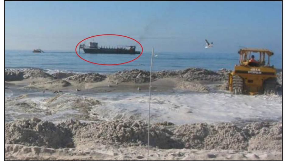
Figura 14. Ilustração do equipamento de dragagem (destacado no círculo vermelho) com cisterna e sistema de bombeamento acoplado à tubulação. Após a transferência à praia, os sedimentos são espalhados e nivelados por máquinas. Fonte: Google Imagens.
