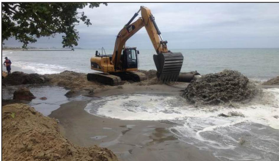
Figura 9. Engordamento realizado na Praia de Piçarras: tubulação ligada à draga bombeando sedimentos na praia com posterior distribuição destes sedimentos utilizando máquinas.
