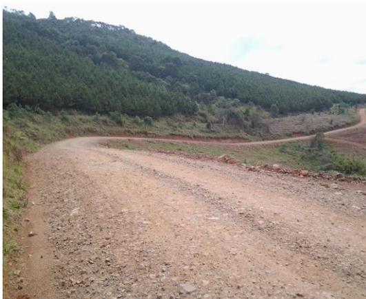
Na imagem à esquerda, estrada rural do município de **Calmon**, cuja superfície de rolamento foi recentemente melhorada através da execução de camada **de revestimento primário constituído de basalto fraturado** (cascalho “in natura”).
