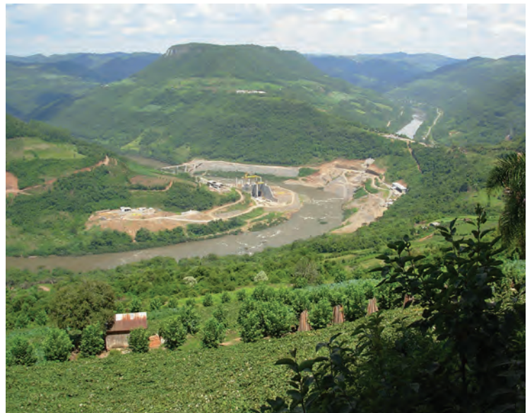
Fig. 8.7 Construção de barragem no rio das Antas, Rio Grande do Sul, antes do desvio do rio, para possibilitar a implantação da barragem propriamente dita. Nota-se a construção de uma estrutura de concreto (vertedouro)
