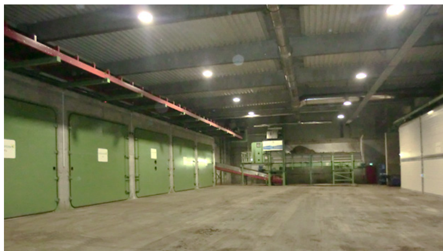
Figura 13: Digestão seca descontínua (Güthersloh, Alemanha)
