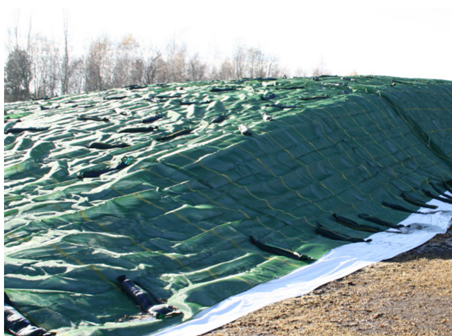
Figura 8: Silo de superfície para armazenamento de substratos sólidos
