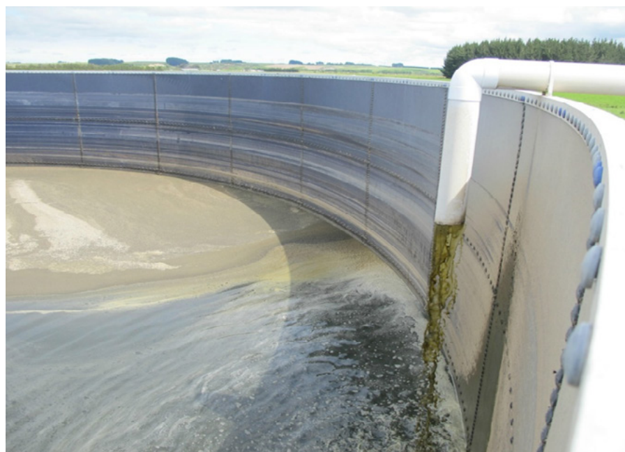
Figura 7: Tanque de aço vitrificado para armazenamento temporário de substratos líquidos
