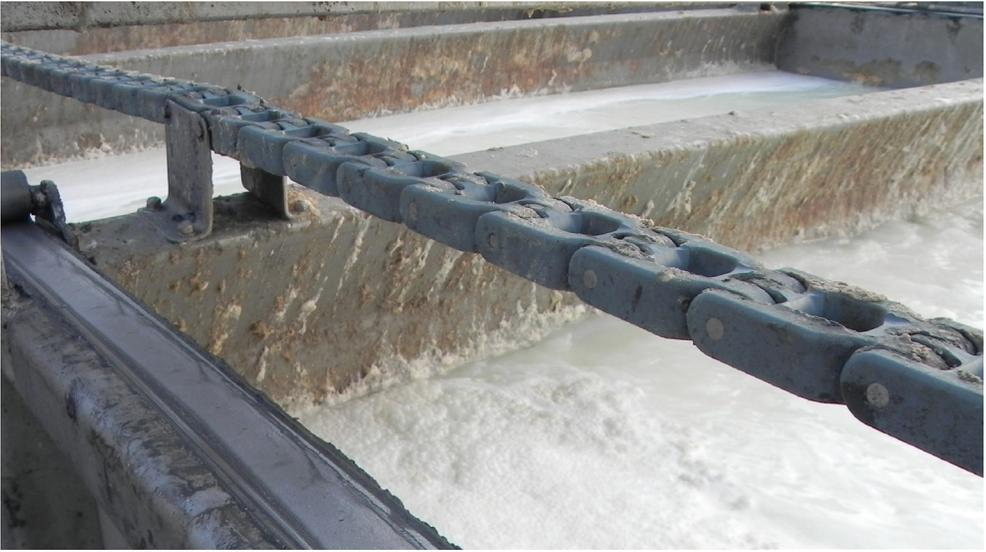
**Figura 21** – Flotador para separar partículas líquidas ou sólidas de uma fase líquida
