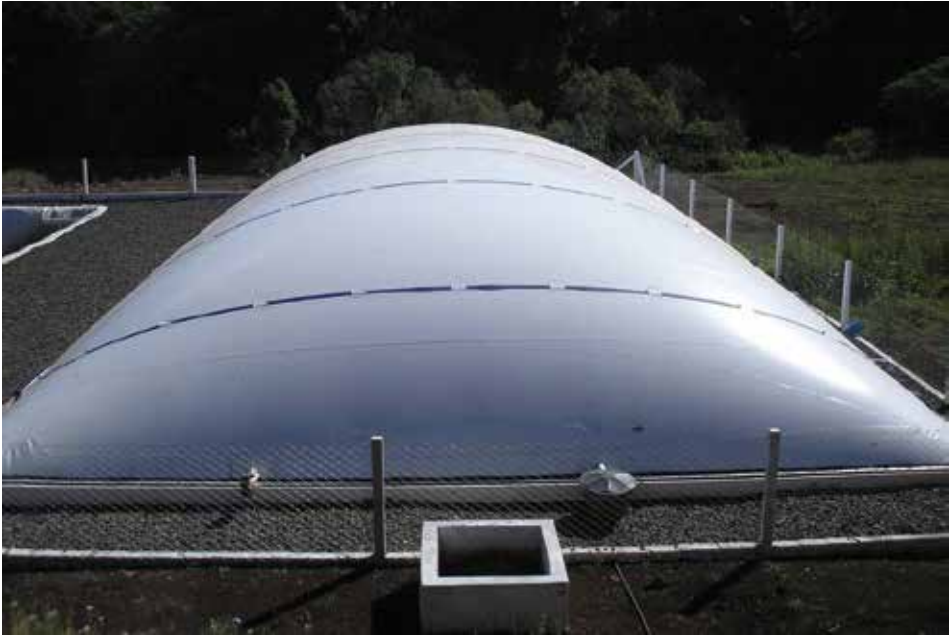
Figura 9 – Lagoa coberta utilizada na suinocultura para o tratamento de dejetos.
