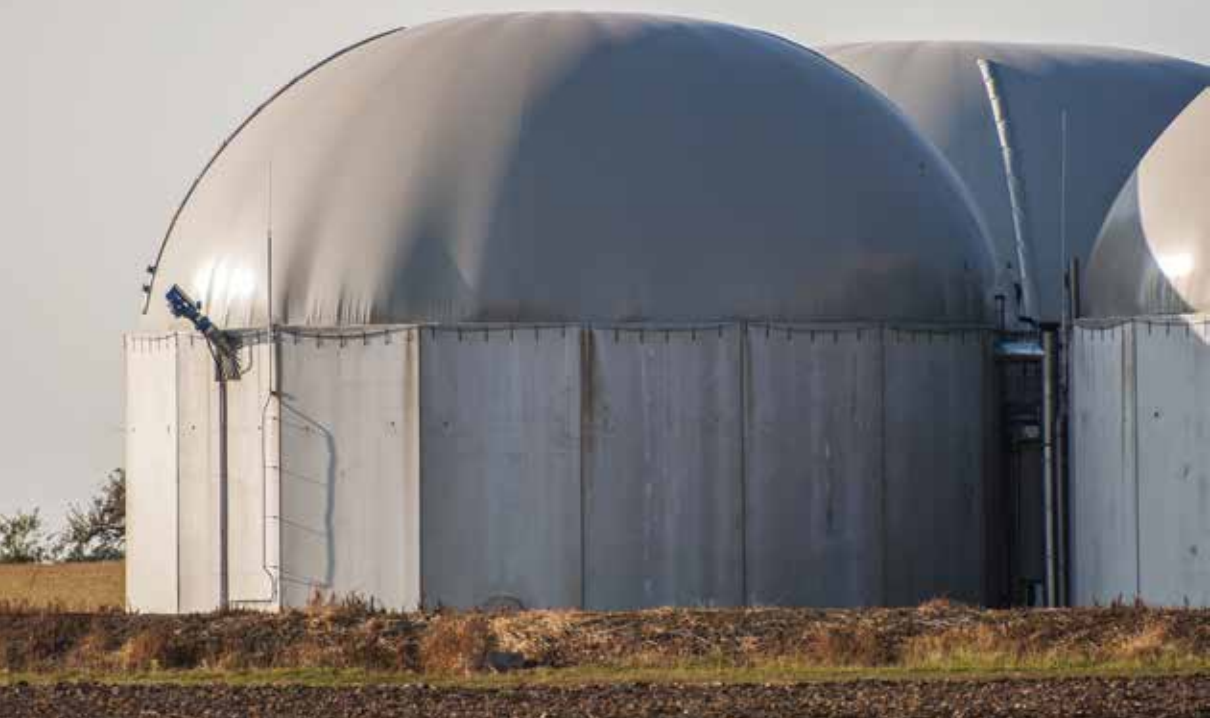
Figura 8 - CSTR de uma planta de biogás.
