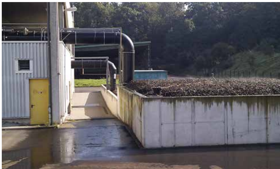
Figura 37 - Biofiltro utilizado em usina de biogás, na Alemanha. Fonte: Nimbin Valley, 2015.
