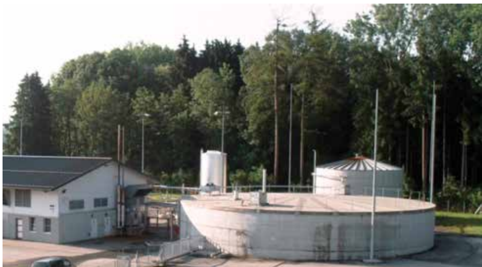
Figura 16 – Vista parcial da usina de biogás de St. Martin, na Áustria.
