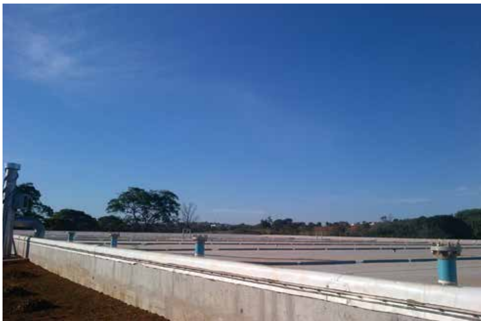
Figura 20 – Reator anaeróbio implantado na indústria Laticínios Bela Vista Ltda.
