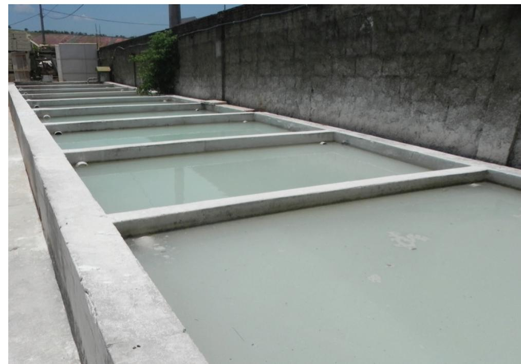
Comumente, os empreendimentos drenam esse tipo de efluente para sistemas simples de decantação. O tratamento consiste em uma sequência de tanques que promovem a deposição em camadas de materiais densos pela força da gravidade. A implementação desse controle permite o reuso da água no processo; já existem iniciativas do reaproveitamento para outros fins dos finos retirados no tratamento.
