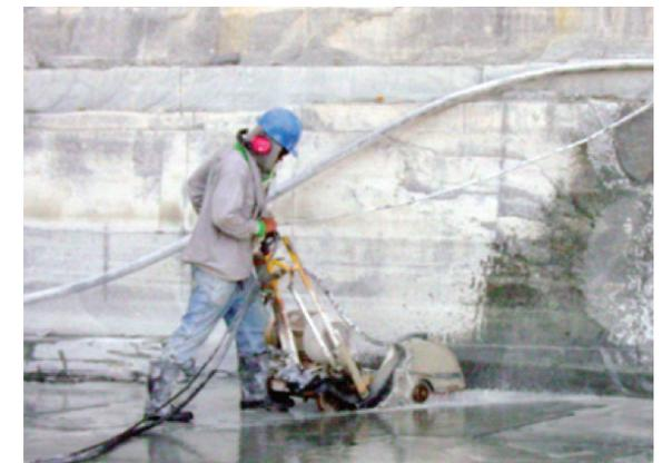
Figura 3 - Corte com serra acoplada em carrinho
