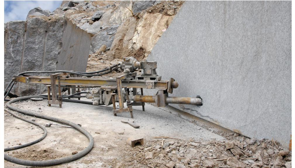
**Figura 9** - Técnica de perfuração para corte com fio diamantado
