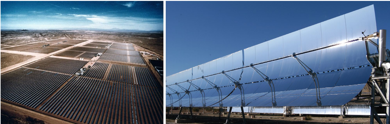
Figura 6. Arranjo geral e detalhes da calha parabólica
