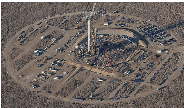
Figura 27. Fundação de torre solar
